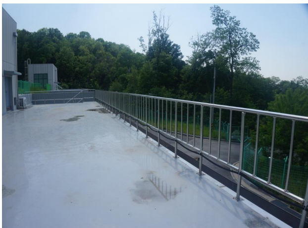
유입밸브실 상부 안전난간 상태양호
