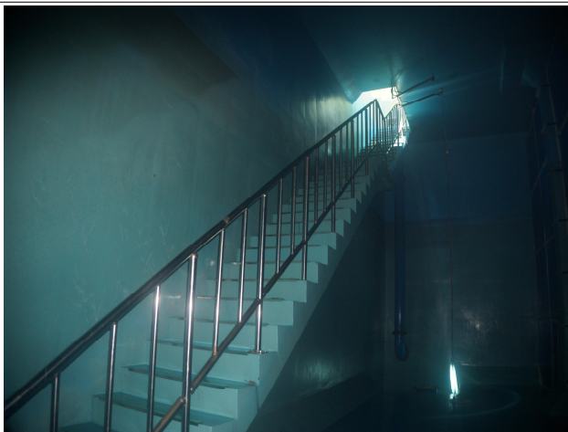
배수지 내부 안전난간 상태양호
