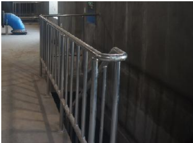
유입밸브실 내부 안전난간 상태양호
