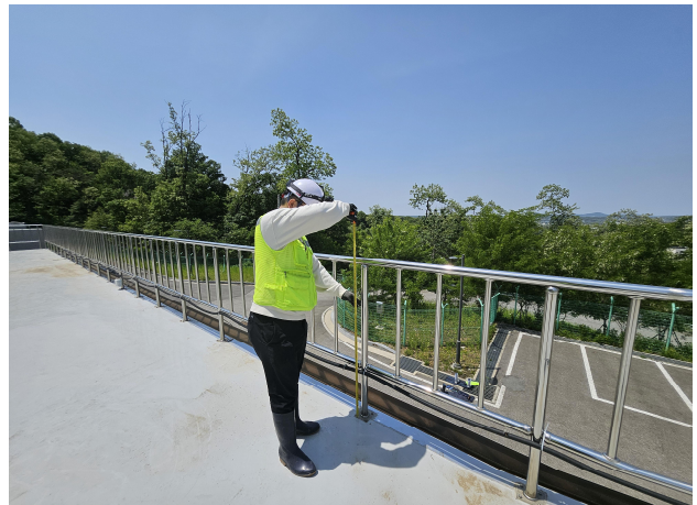
유입밸브실 상부 안전난간 상태양호
