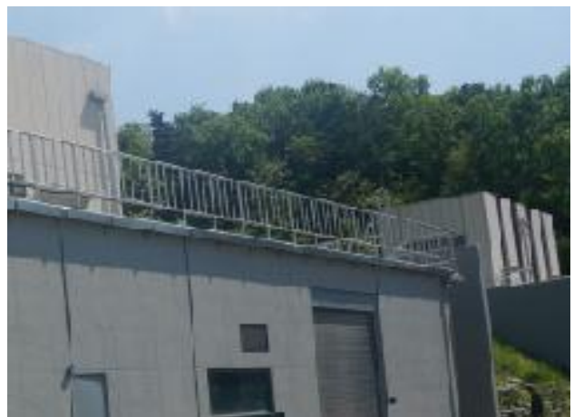
유입밸브실 상부 안전난간 상태양호
